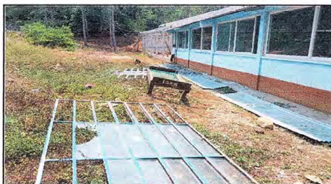
Foto 3: INICIO DE CAMBIO DE VALCONES DE LAS AULAS
