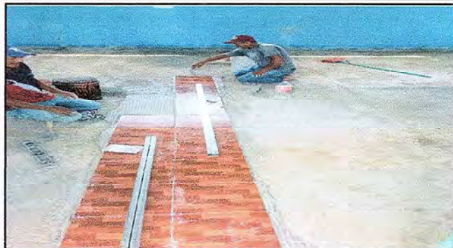
Foto 2: AVANCES SOBRE EL PEGADO DE CERAMICA
