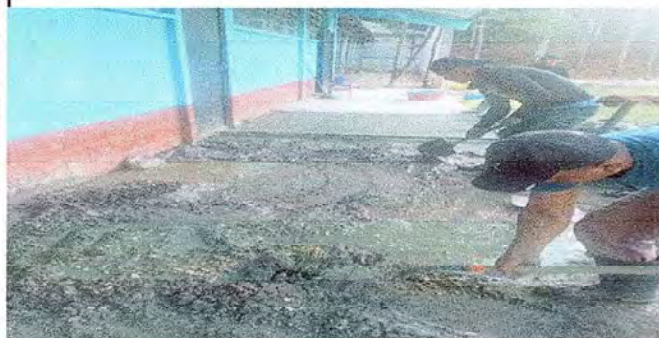
Foto1: AVANCES DEL TRABAJO PARA LA COLOCACION DE LA CERAMICA EN TRES AULAS Y CORREDOR
